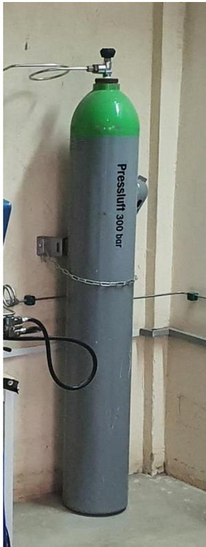
Das Ventil der Pufferflasche ist defekt, lässt sich nicht schließen. Auch hier wird erst einmal ein Austausch mit einer Reserveflasche vom Festland erfolgen. Wir werden versuchen, Reparaturteile für den Ventiltyp zu erhalten.
