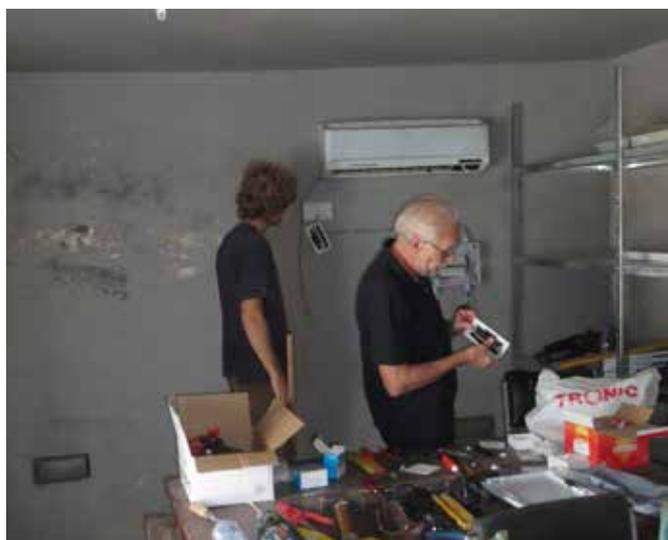
Bereich. Eine nähere Untersuchung der vorhandenen Elektroinstallation durch den SES Experten und Elektromeisters Holger Thode ergab, dass in dem neben dem Werkstatttraums befindlichen Raucherzeugungsraum eine Phase mit einer 4 Quadrat Leitung befand. Durch die ehemaligen Rauchzuleitungsrohre war es daher sehr einfach,
