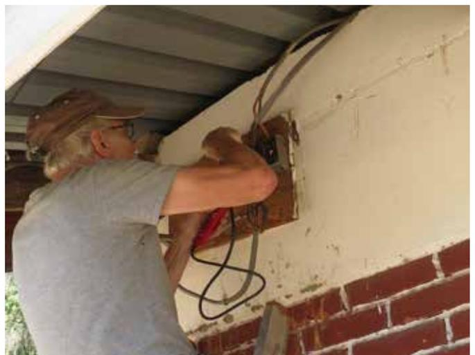
Stromanschluss, genutzt wurde aber nur eine Phase, für die anderen mussten erst Hauptsicherungen beim tansanischen Stromversorger
