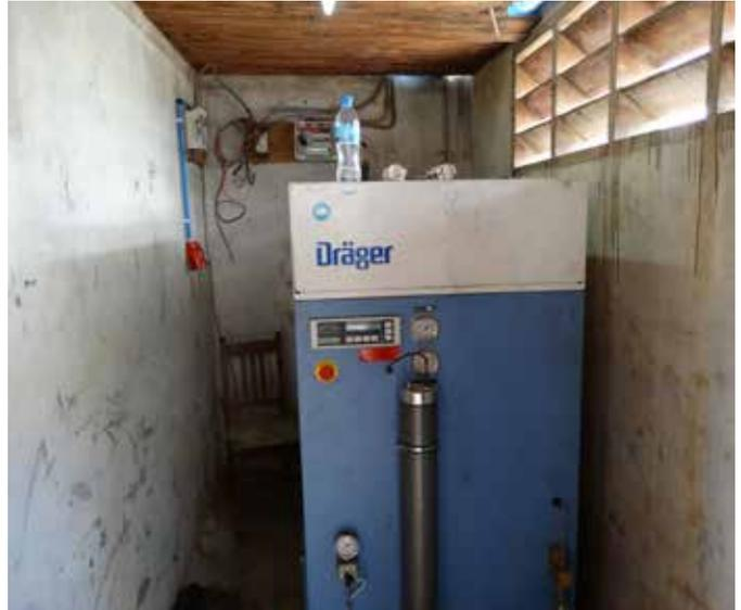
Die Verbindung zwischen Kompressor und Füllleiste erfolgte für die Druckluft mit Ermeto Hochdruck Stahlrohre, für die Verbindungen wurden Edelstahl Verschraubungen verwendet. Über der Füllleiste wurde ein Steuergerät montiert.
