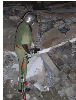
Mit der Schere wird die Armierung durchtrennt
