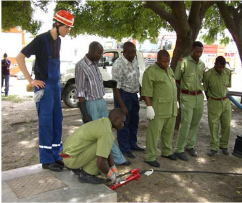
Arbeiten mit einfachem Spritzersystem
