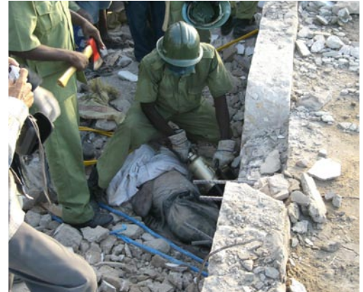
Mit dem Spreizer wird ein Bauarbeiter geborgen
