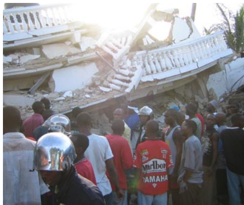
Totaleinsturz des Neubaus
