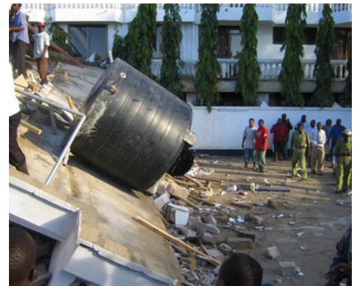
Der große Kunststoffwasser-tank wird vom Dach geworfen
