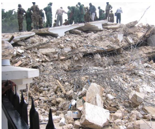
Aufräumarbeiten "längere Zeit"
