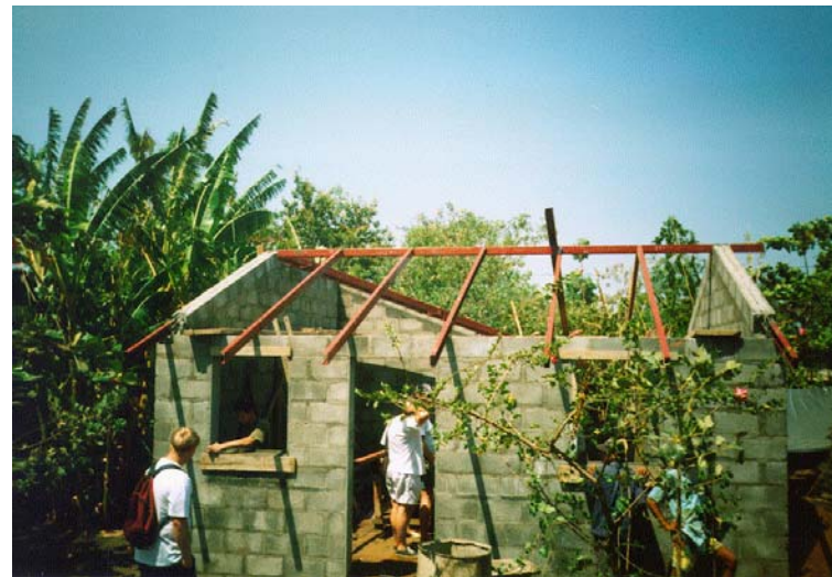
Ein Haus im Rohbau
