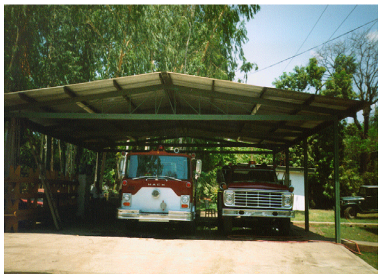
Die Betriebsfeuerwehr in der Zuckerfabrik
